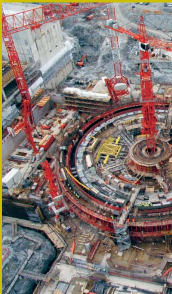
Stavba evropského tlakovodního reaktoru EPR ve finském Olkiluotu měla být ukázkou „renesance“ jaderné energetiky. Jenže se nic nezměnilo: stále výrazně dráže a výrazně později. Foto: © Greenpeace / Nick Cobbing
